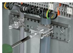
Nach dem Aufstecken die Rändelschraube festdrehen.
