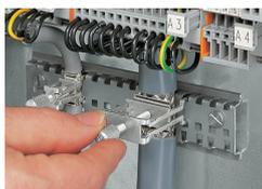
Festdrehen/Lösen eines Schirmklemmbügels
