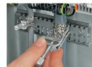
Zum Demontieren eines Schirmklemmbügels die Rändelschraube über den Druckpunkt hinaus aufdrehen und Klemmbügel unter leichtem Abkippen entnehmen.
