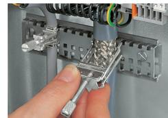
Festdrehen/Lösen eines Schirmklemmbügels
