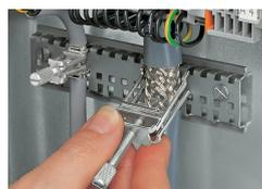
Festdrehen/Lösen eines Schirmklemmbügel
