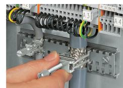
Träger mit Ableitfuß\* (790-113), 45 mm lang, 90° zur Tragschiene
