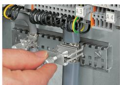
Festdrehen/Lösen eines Schirmklemmbügels
