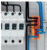
In Verbindung mit dem als Zubehör erhältlichen Befestigungsadapter können die Klemmen in der Lage fixiert und beschriftet werden. Der mit maximal 2 Klemmen ausrüstbare Befestigungsadapter kann auf der Tragschiene DIN 35 aufgerastet oder mittels zweier Schrauben auf glatter Oberfläche befestigt werden.
