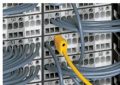
Prüfen mit Prüfstecker (210-137) Ø 2,3 mm
