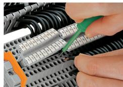
Der über den Verdrahtungsebenen stehende Beschriftungsträger wird während der Verdrahtung oder Brückung automatisch zur Seite gebogen. Die in der Höhe versetzt angeordneten Aufnahmeprofile für WMB-Beschriftungsschilder sind den „Stockwerken“ eindeutig zugeordnet.
