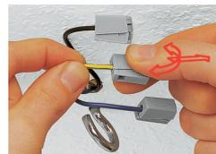
Leiter anschließen: Abisolierten eindrängigen Leiter bis zum Anschlag in die runde Öffnung hineinstecken.
