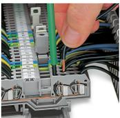
Das oben angebotene Betätigungswerkzeug mit teilisoliertem Schaft eignet sich aufgrund der Klinsenabmessungen besonders für die Betätigung von Reihenklammen mit Frontverdrahtung.
