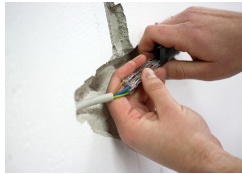
Leitung mit Leitungsreparaturset verbinden.
