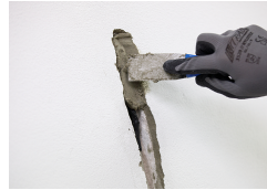
Schadstelle unsichtbar verschließen.
