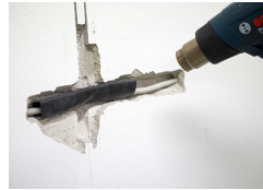
Schrumpfschlauch erhitzen und Schadstelle wieder fachgerecht verschließen.
