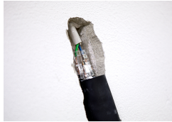
Leitung mit Leitungsreparaturset verbinden.
