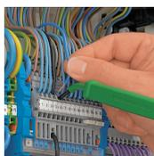
Ouverture du point de connexion à l'aide d'un outil de manipulation
